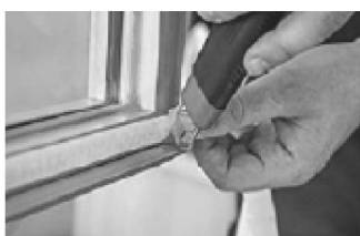
Obr. 3: Zkrajte upínací pásku na rozích.
